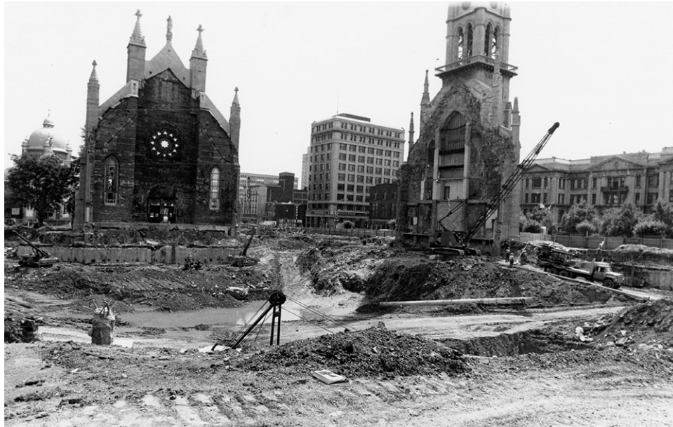
Figure 8 Chantier du site de l'église Saint-Jacques, [entre 1973-1979] (UQAM. SAGD, Fonds d'archives du Service des communications, 45U-412:F3:05/8 3/13 (GFO 457-458))
