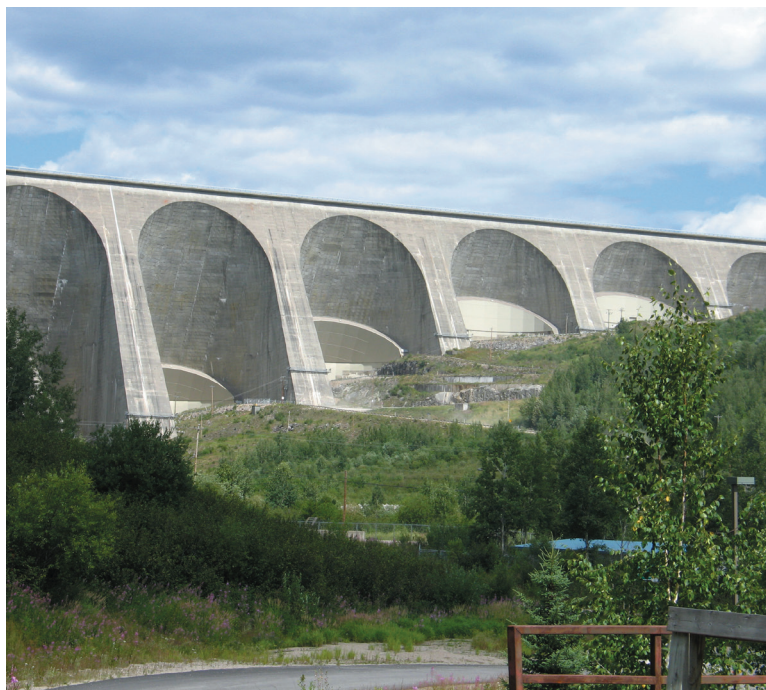
Le barrage Daniel-Johnson, pièce maîtresse de l'aménagement électrique Manic 5 d'Hydro-Québec. | Photo: Claude Boucher
