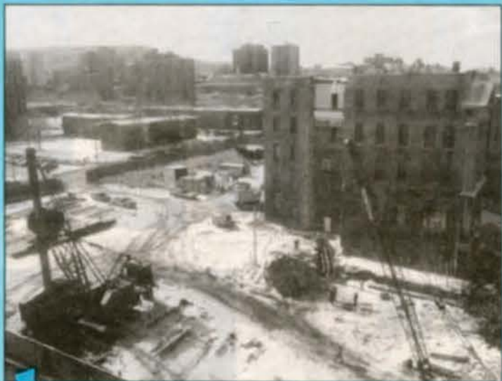
Les travaux d'aménagement vont rondement sur l'emplacement Athanase-David, bordé par les rues Sainte-Catherine, Saint-Denis, boul. DeMaisonneuve et Sanguinet. On aperçoit, vu du sud, le bâtiment de l'ancienne École polytechnique, dont la façade et le corps principal de bâtiment s'intégreront au futur ensemble immobilier
