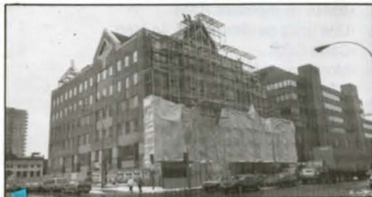
Le bloc « W » en voie d'être complété.
